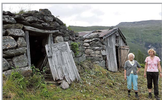
I SISTE LITEN: Selet var sterkt merkt av forfall slik me ser av biletet. Taket var sige saman, vindaugo er utan glas og dei mura steinveggene er byrja å rasa saman. – No bergar me eit flott støls- og kulturminne frå forfall, seier Kristin Sønnerheim t.v. og Sigrid Sønnerheim Tønnessen.
